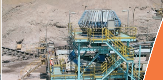
Filtración de estériles < 200µm. 150 t/h
